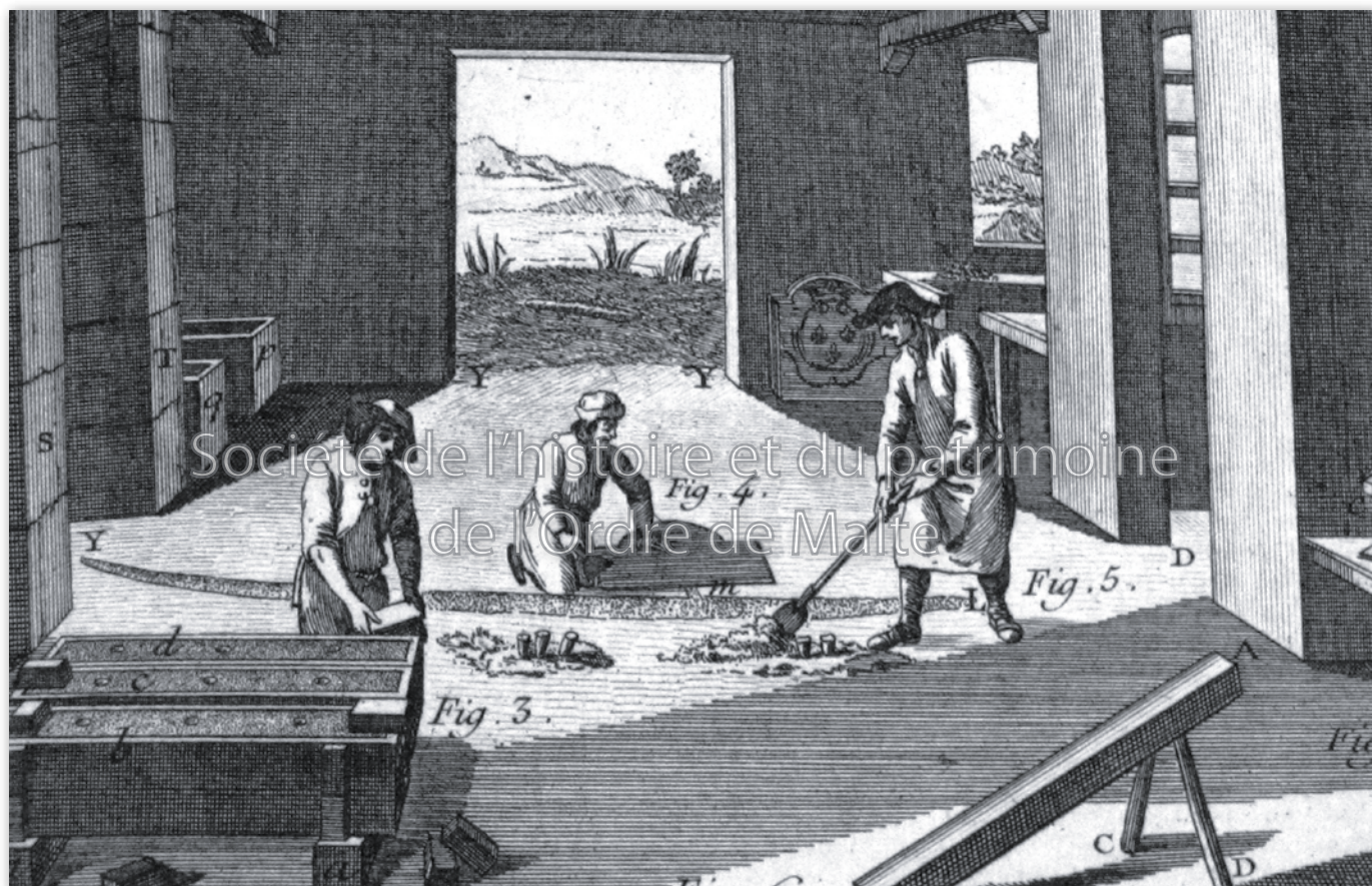
Fig. 1 - La coulée d'une taque. (cl. X. Quenot)
